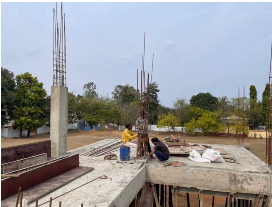
Indienreise: Die Baustelle des Jungenboardings in Junwani am 13. Februar 2024
