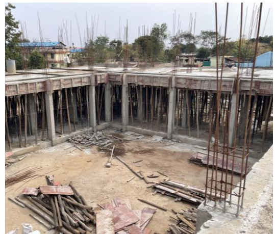
Es geht voran: die Baustelle des Jungenboardings in Junwani
