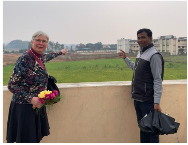
Hier entstehen die neuen Wohnunterkünfte für jeweils 50 Mädchen und Jungen
