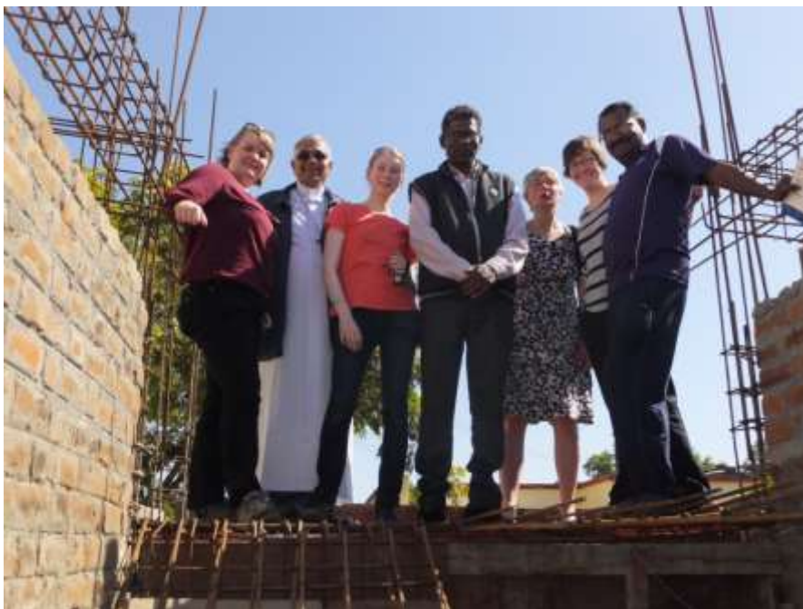
Auf der Baustelle der neuen Wohnunterkunft für Jungen in Amarpur
